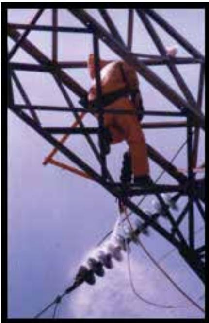
Es un **sistema de lavado de aisladores** capaz de remover cualquier incrustante hasta recuperar la superficie lisa y vidriada, sean éstos de porcelana o vidrio. Puede usarse en líneas desenergizadas y en instalaciones en vivo o calientes, con un alto grado de confianza en sus bondades para no ocasionar fallas del aislamiento a tierra.
